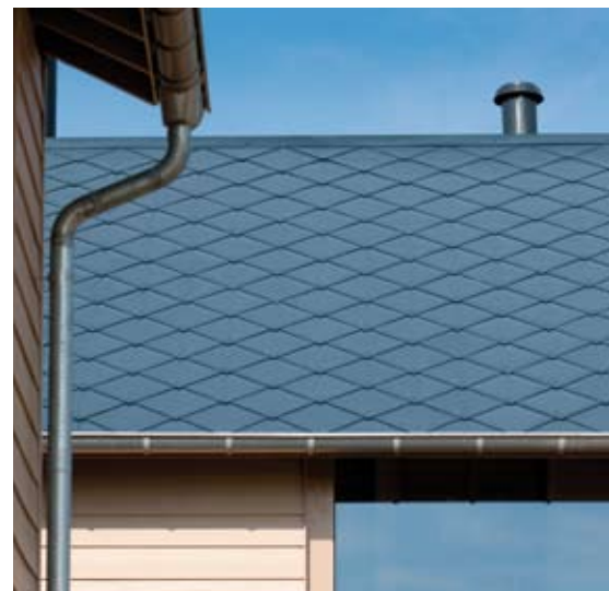
De dakbedekking van alle woningen wordt uitgevoerd met ruitleien van Eternit. Le revêtement du toit de toutes les habitations est réalisé avec des ardoises losanges Eternit.
